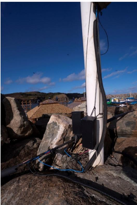
**Fig. 11** (acima) e **Fig. 12** (esquerda) – Estrutura presente do molhe do porto de Santo Antônio, elucidando cabo, fios elétricos e ductos expostos.
